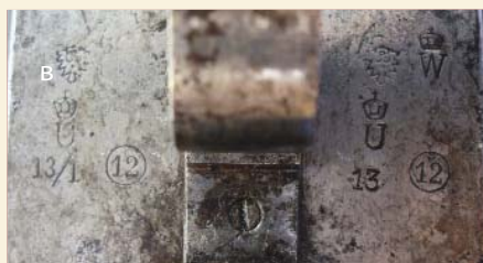
11. Образцы маркировки калибра стволов под различные типы гильз
